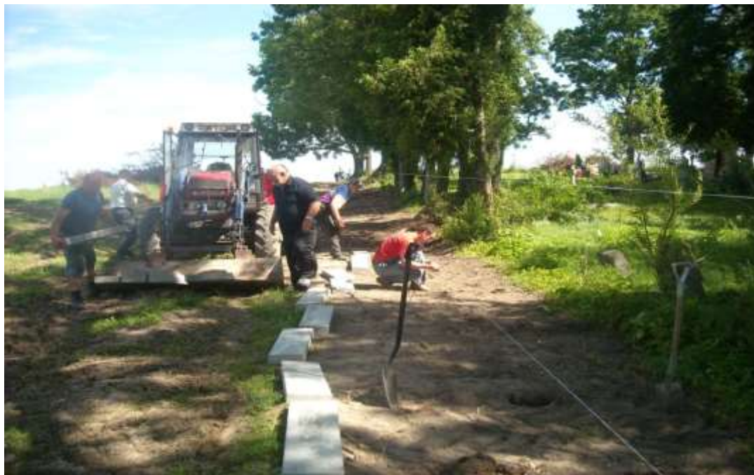
Rys. 10 Prace budowlane związane z wykonaniem nowego ogrodzenia na cmentarzu w Blankach w ramach projektu „Nasze dziedzictwo”
