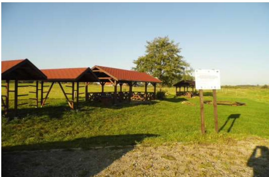
Mała infrastruktura turystyczna przy przystani kajakowej na rzece Łynie w miejscowości Łaniewo
