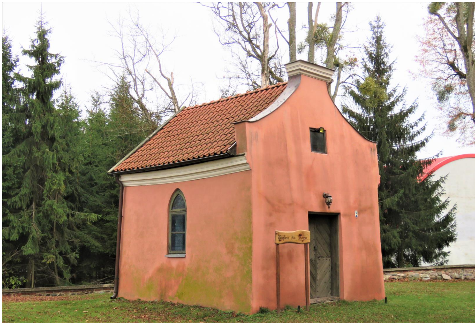
Widok ściany frontowej i wzdłużnej kaplicy z SW na NE
